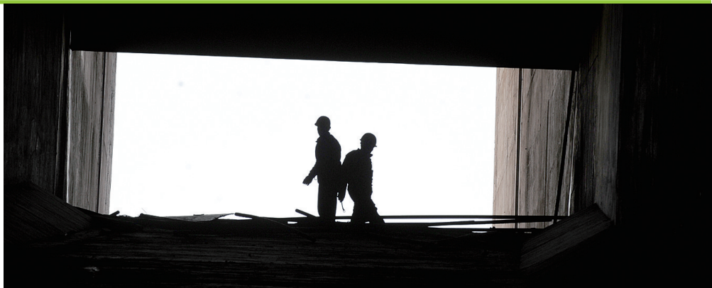
南水北调中线鹤壁段共设有4个倒虹吸。
