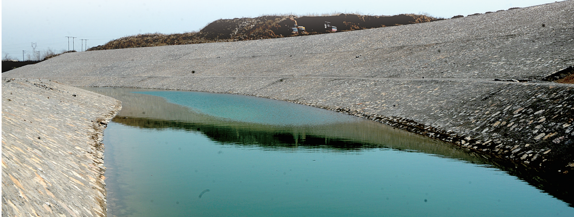
南水北调干渠通水之后，这里将呈现这样的场景：淇河依旧东西流向，而在淇河河床下，南水北调干渠则是南北走向。
