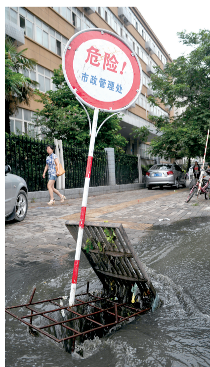
建设路桐柏路口,市政工人打开窨井盖排水
