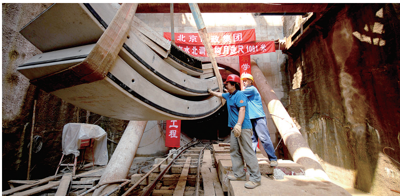
南水北调工程北京段施工现场
