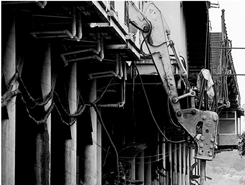
拆除已经在进行
