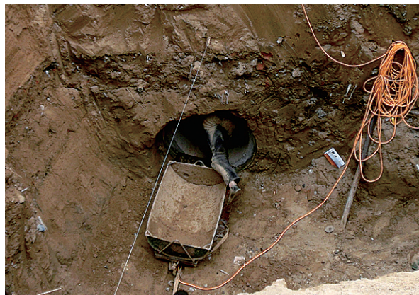
抓着绳子下到5米深的坑底,趴到水泥管里干活。
