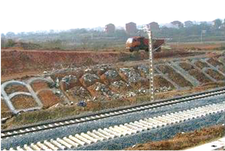
正在施工的太兴铁路
