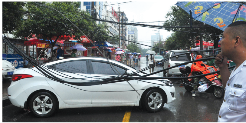
农业路南50米处的政七街上电缆线低垂,过往车辆调头行驶。
