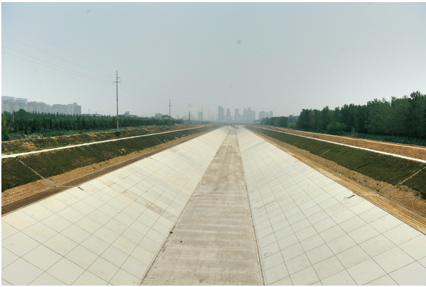
横穿常西湖新区、中原新区的南水北调干渠即将通水
