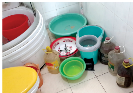
卫生间里摆满了接水的盆盆罐罐。
