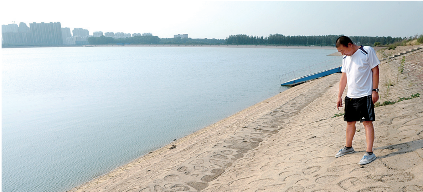
在石佛沉砂池,自来水公司柿园水厂工作人员站立的地方是以前的正常水位,现在的水位足足降低了两米。
