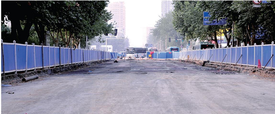
文化路西半幅平坦的路面下,大部分雨水、污水等管线已铺设完毕
