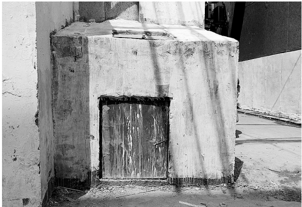
汝河路楼院内新建好的公用垃圾池
