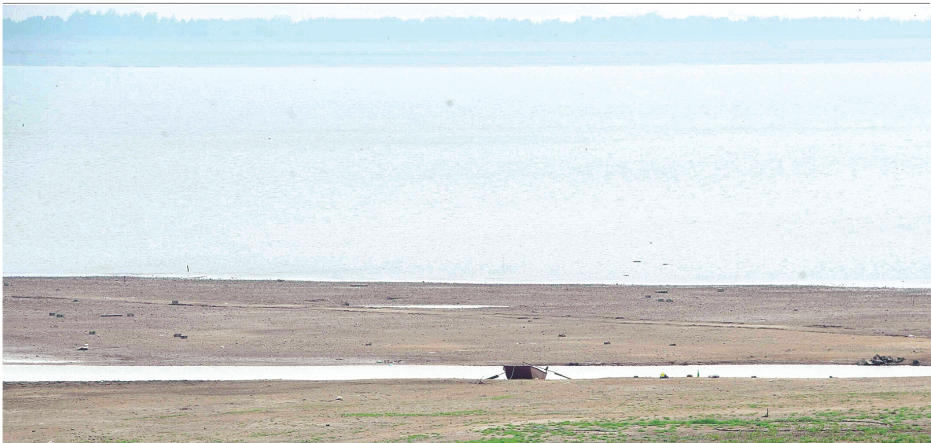
平顶山市饮用水源地白龟山水库水位严重下降。
