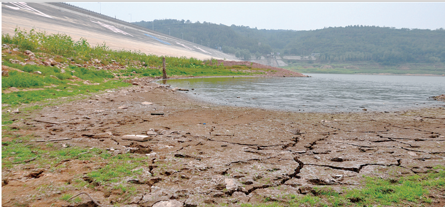
李湾水库缺水现状,水库出现满水位已是11年前。
