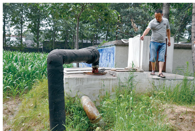
自来水公司在王庄排水阵地新修的工程
