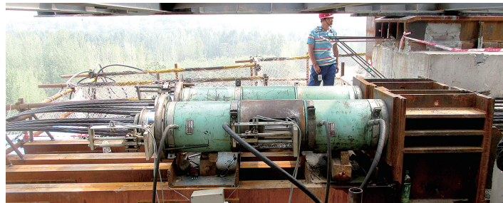
墩柱旁提前安装的千斤顶
