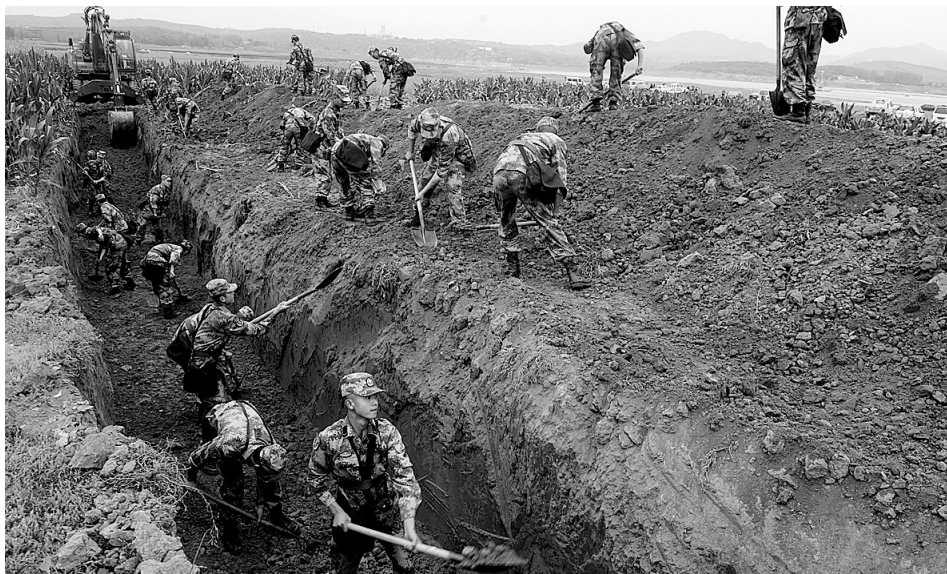
抗旱引水工程施工现场 郑州晚报记者 马健 图
