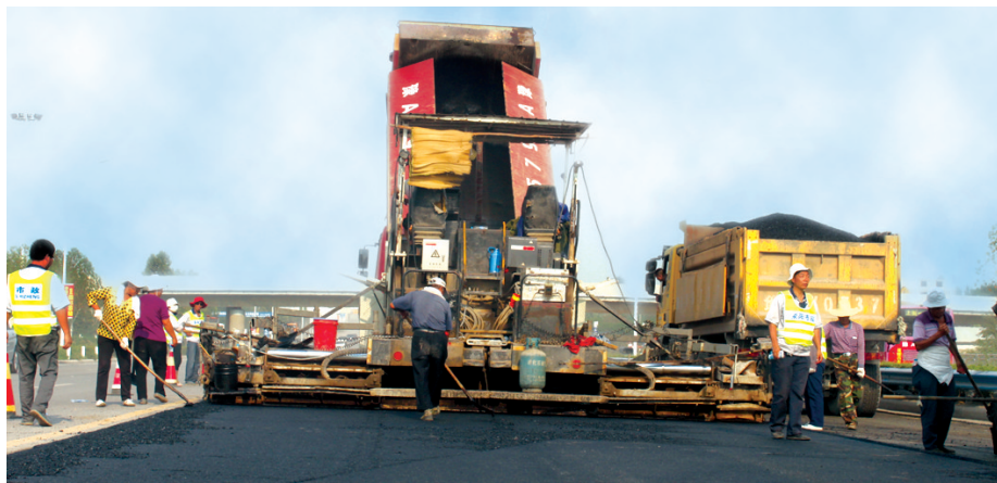
中原西路荥阳段维修施工现场
