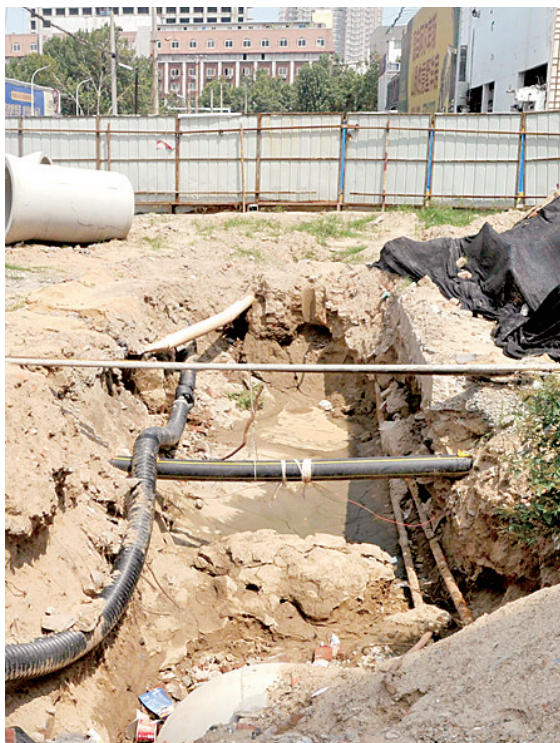
金水路南边的城东路上,围挡内一直处于停工状态。
