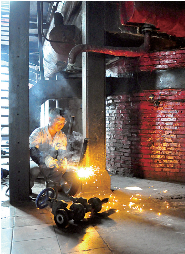
金星啤酒厂工人正在用切割机拆除燃煤锅炉
