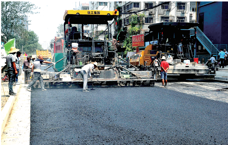
图为8月15日道路正在铺设沥青,目前快车道底层沥青已施工完毕。资料图
