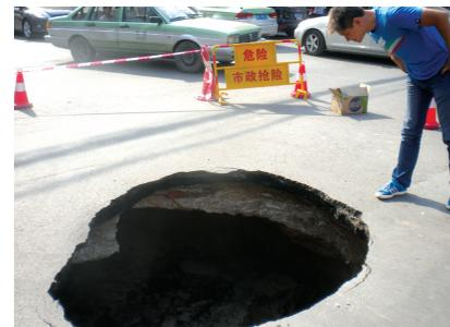
昨日凌晨,南阳路东风路交叉口正中央的路面发生塌陷,一个2米多深的坑让随后的上班早高峰交通更为拥堵。塌陷原因初步认定为坑内的水冲塌了路基。 郑州晚报记者 潘登 文/图
