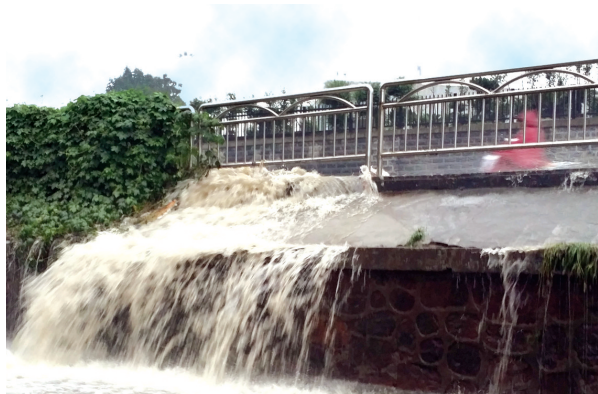
昨天傍晚5点半左右,航海路铁路立交桥,大量雨水从慢车道倾泻到快车道上,形成一个两三米宽的“瀑布”,幸好快车道排水较顺畅,当时未形成影响交通的积水。 郑州晚报记者 马健/图
