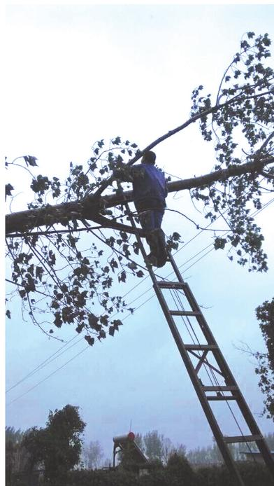
连日阴雨天气,使分布在田间地头的东周水厂水源地架空线面临严峻的挑战,高大树木因大风或雨水浸泡不时出现倒伏,导致突发断电、水井停运。
