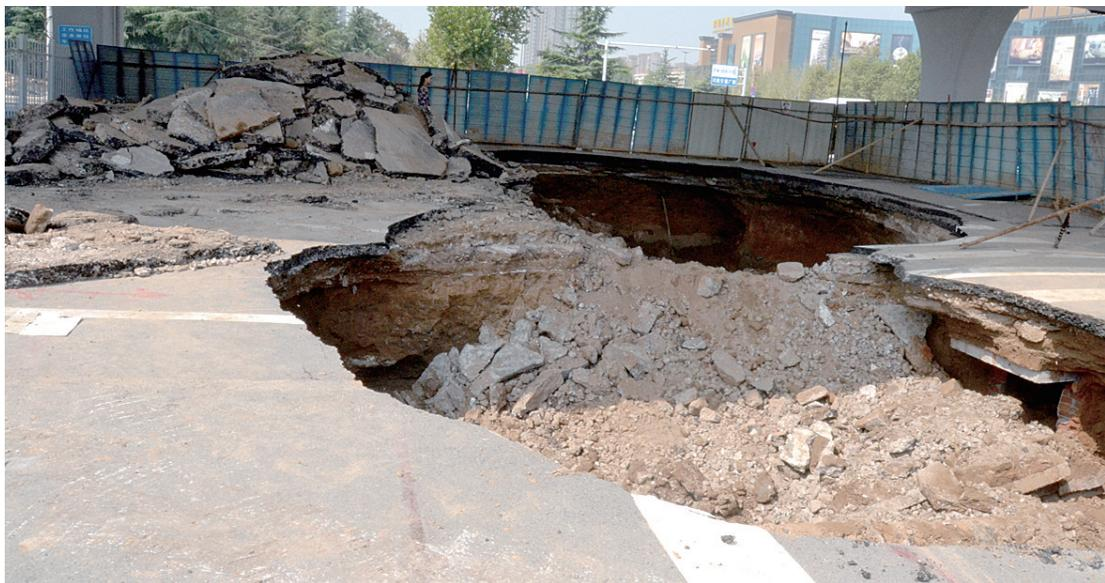
长期降雨停止后，中原路西三环交叉口下的路面塌方，前日夜开工整修。
