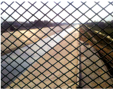
试充水前,渠里已有一些存水。
