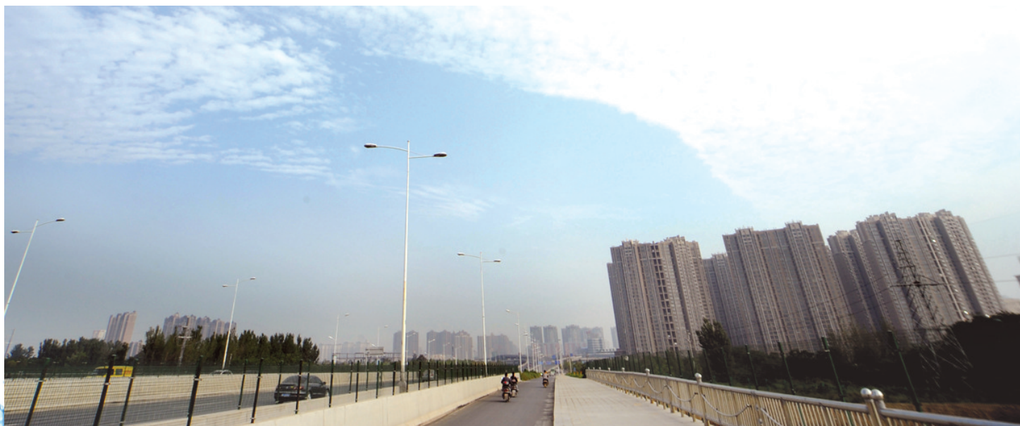
嵩山南路南水北调渠附近正在建设的楼盘
