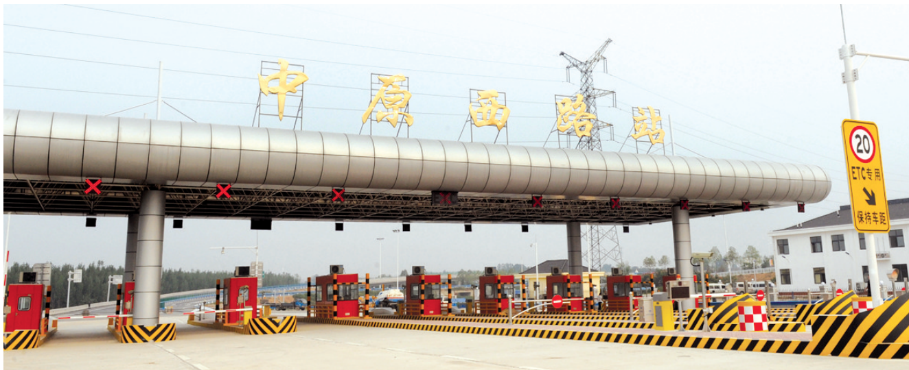
中原西路站建设已经完工
