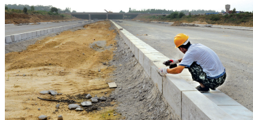
工人正在进行路面硬化施工
