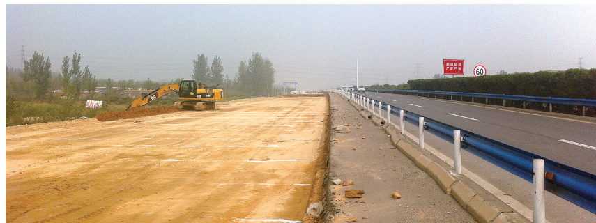
临近机场的一段新修道路已见雏形
