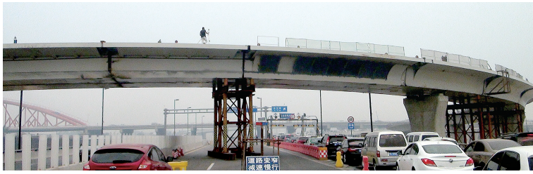
匝道箱梁已经合龙,工人们在桥上施工
