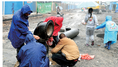
在农业路以北的文化路,工人冒雨安装管道。
