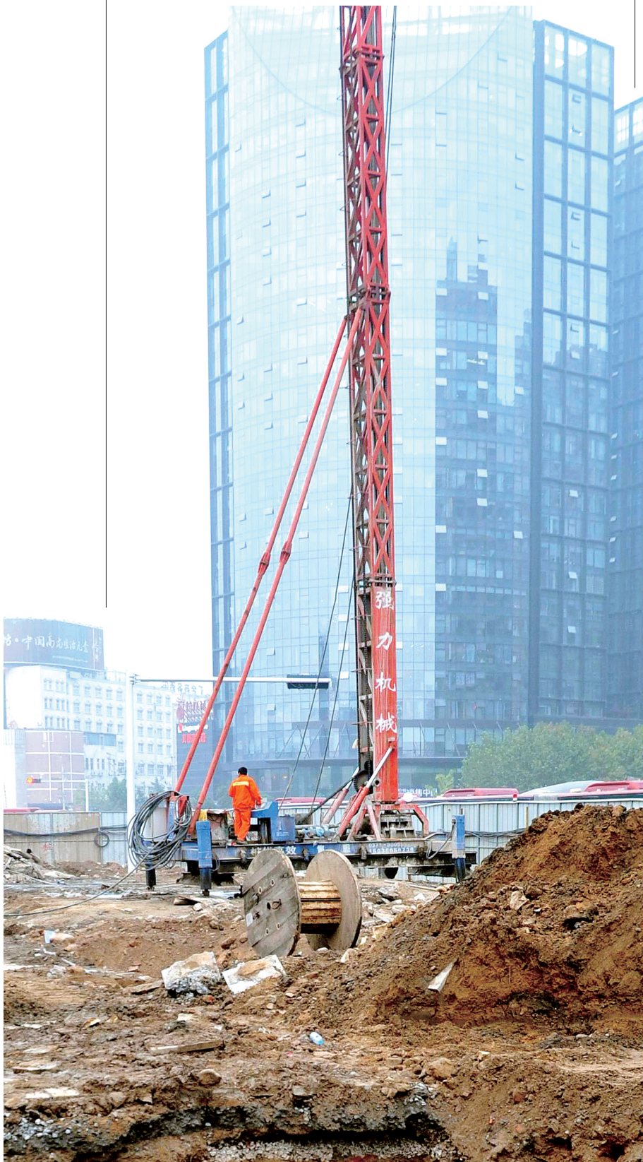
未来路与金水路交叉口西南角下穿隧道工地,因为地下埋有热力管道,导致钻机停工。
