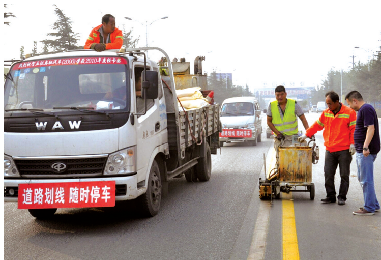
登封市公路管理施工现场
