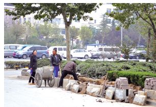
工人正拆除垂柳路绿化带
