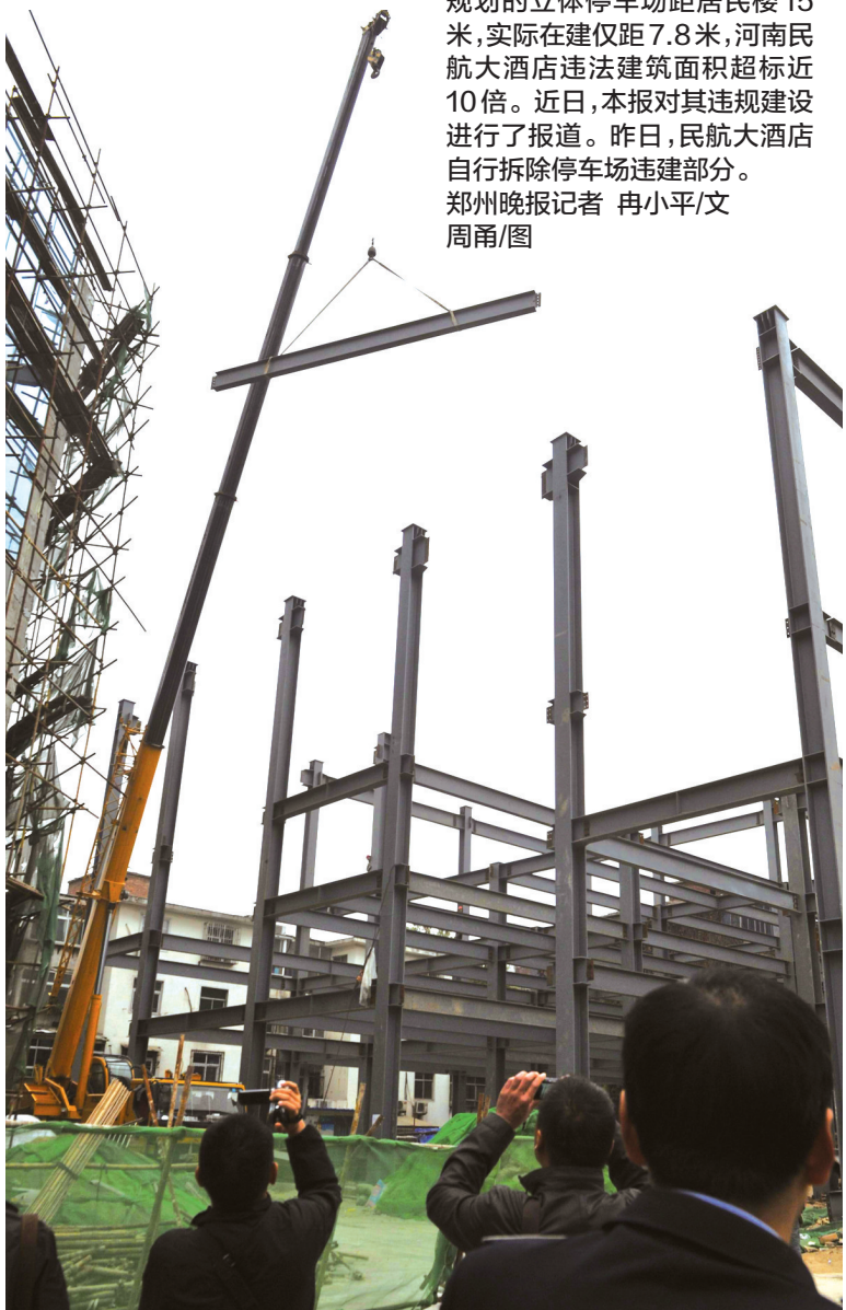
民航大酒店自行拆除违建部分停车场
