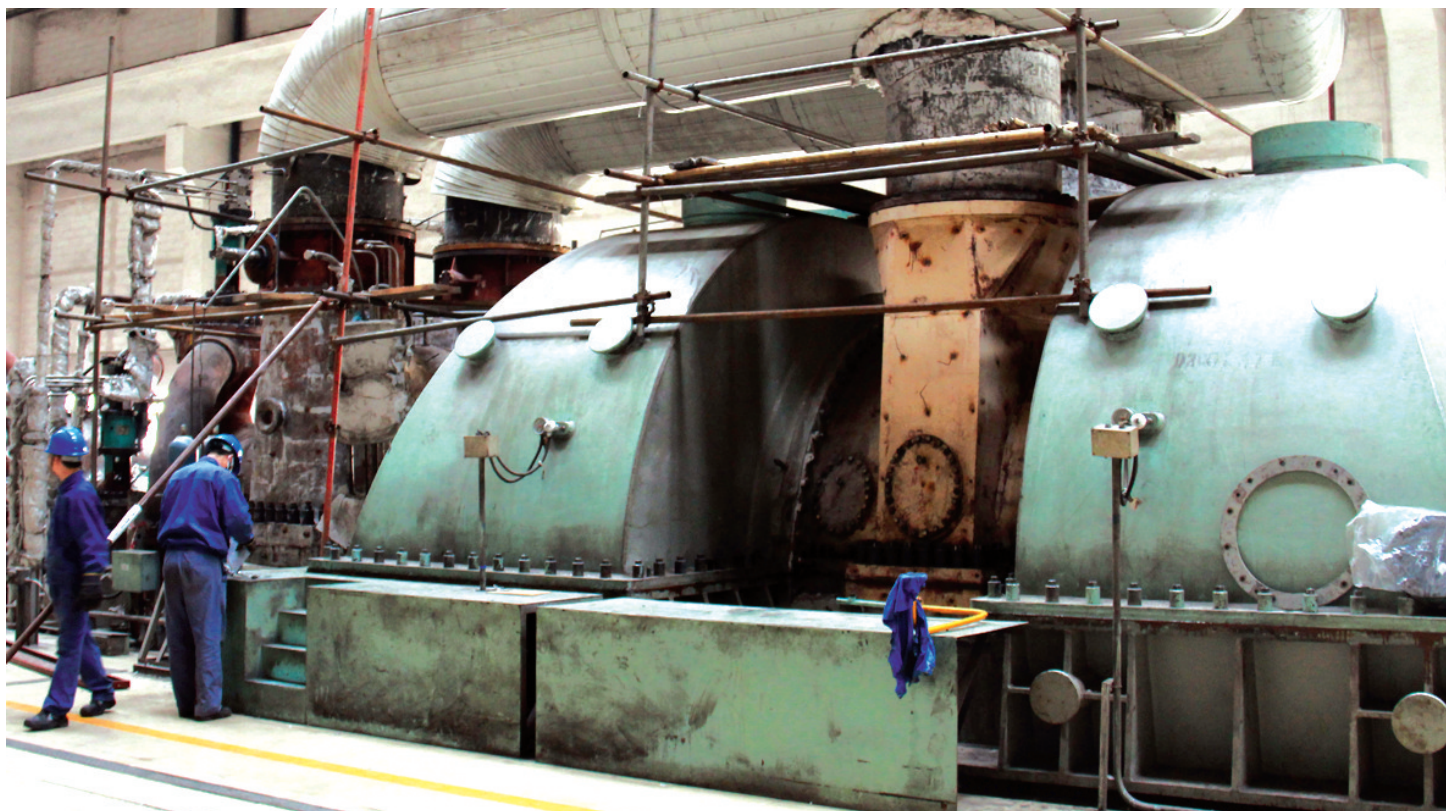
工人在对即将开始供热的设备进行检修维护。
