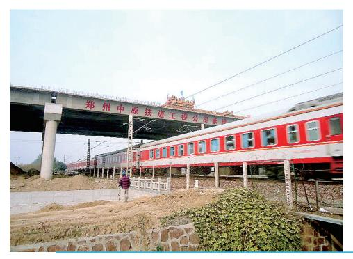
11月7日下午,随着最后一片上跨 桥箱梁的顺利架设完成,由郑州中原铁 道工程有限责任公司承建施工的荥泽 大道跨陇海铁路桥工程成功实现上跨 桥合龙,为下一步桥面铺装及工程早日 建成通车打下了坚实的基础。
