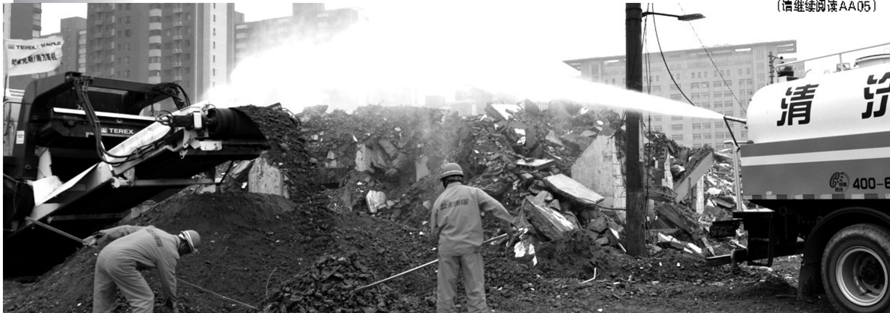
颍河路一工地,渣土被粉碎后用来制作各种再生砖等,有效减少了扬尘。
