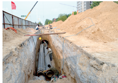
203管网改扩建索河路段施工
