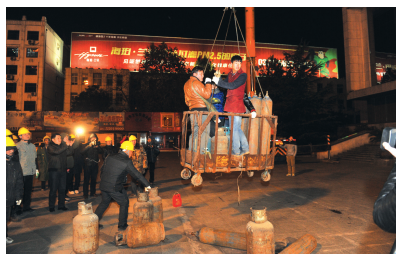
施工人员和气罐起吊
