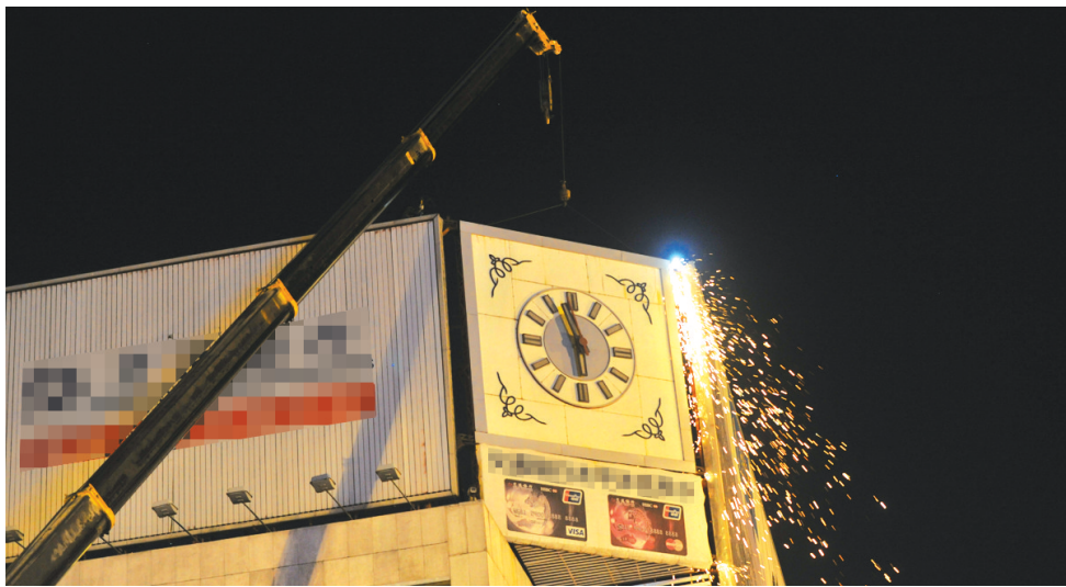
省人民会堂的广告切割拆除开始
