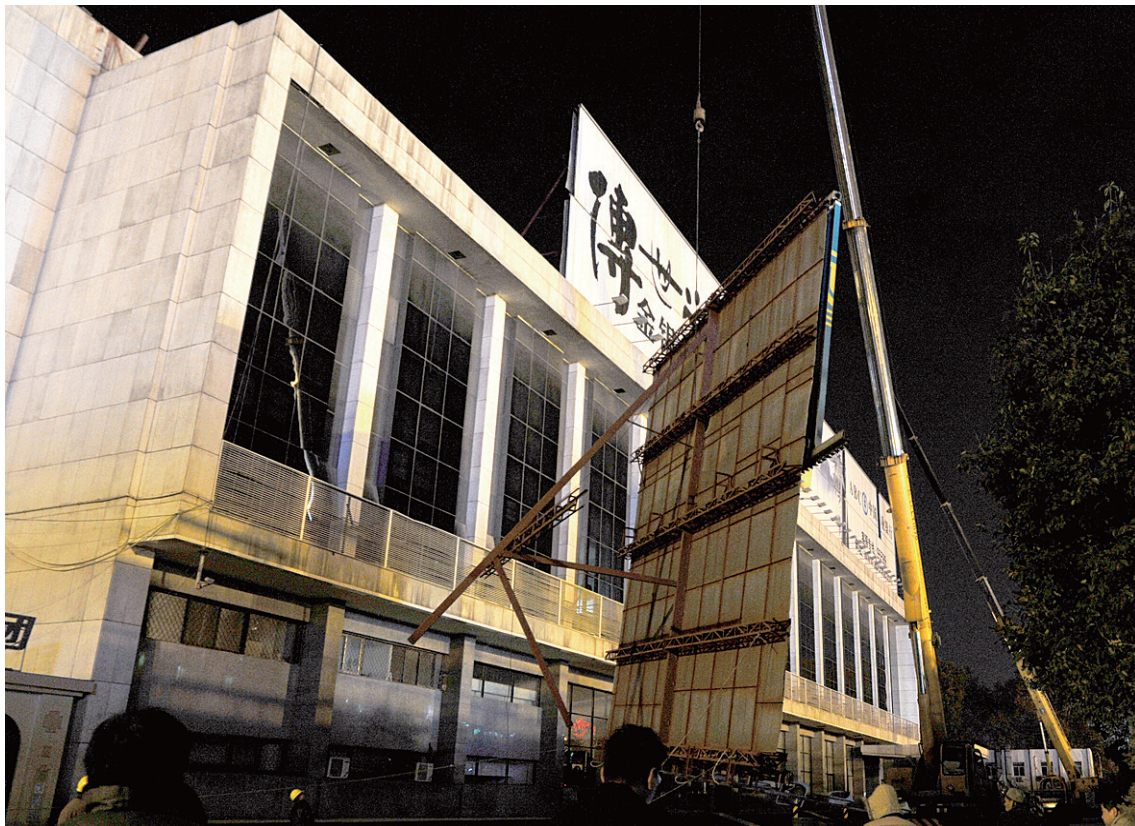
昨晚10点20分,人民会堂南侧广告牌拆解后的一块被吊下。
