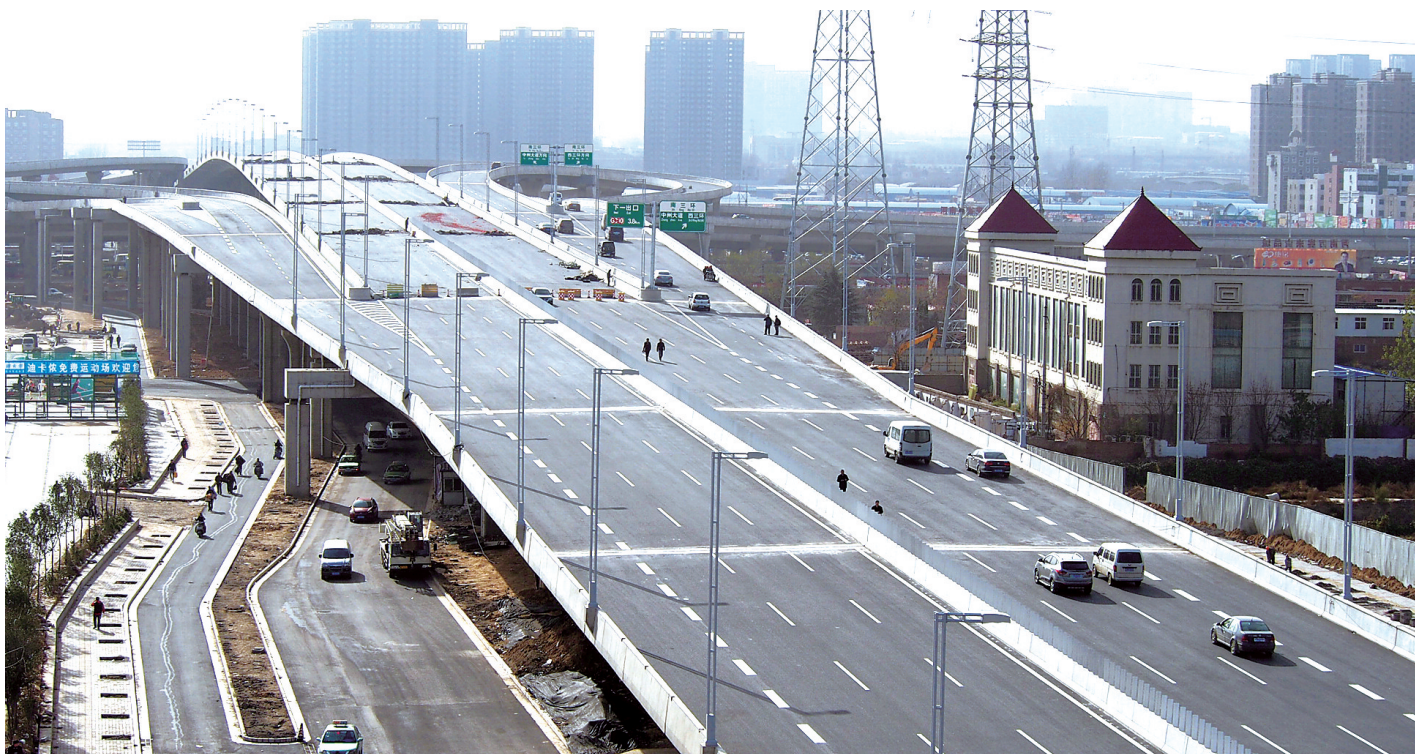
站在京广路南三环立交东北角可以看到,桥上车辆畅通无阻。
