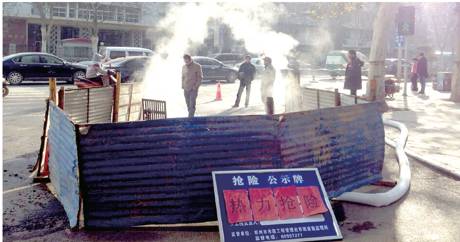
由于地下管网复杂,只能采取人工开挖
