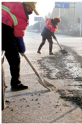
环卫工人清理混凝土
