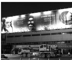
拆除市体育馆楼顶广告牌
