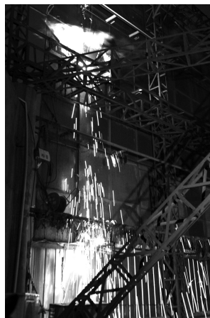
拆除银基广场的广告牌
