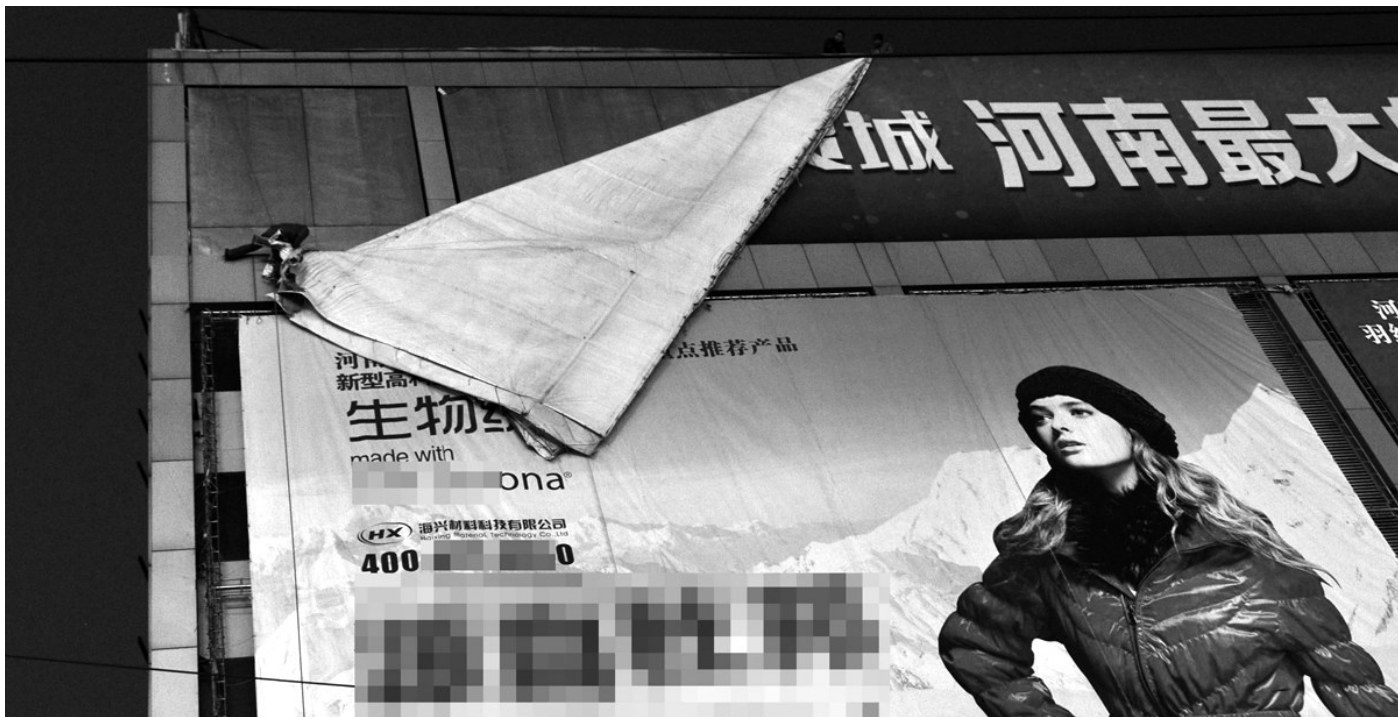
工人正在拆除锦荣商贸城广告墙上的广告布。
