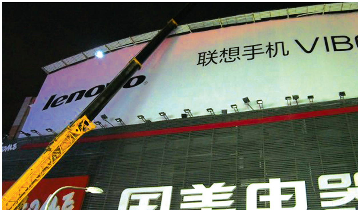
昨晚11点,位于二七广场南侧德化街北口国美电器楼屋顶户外广告牌开始拆除
