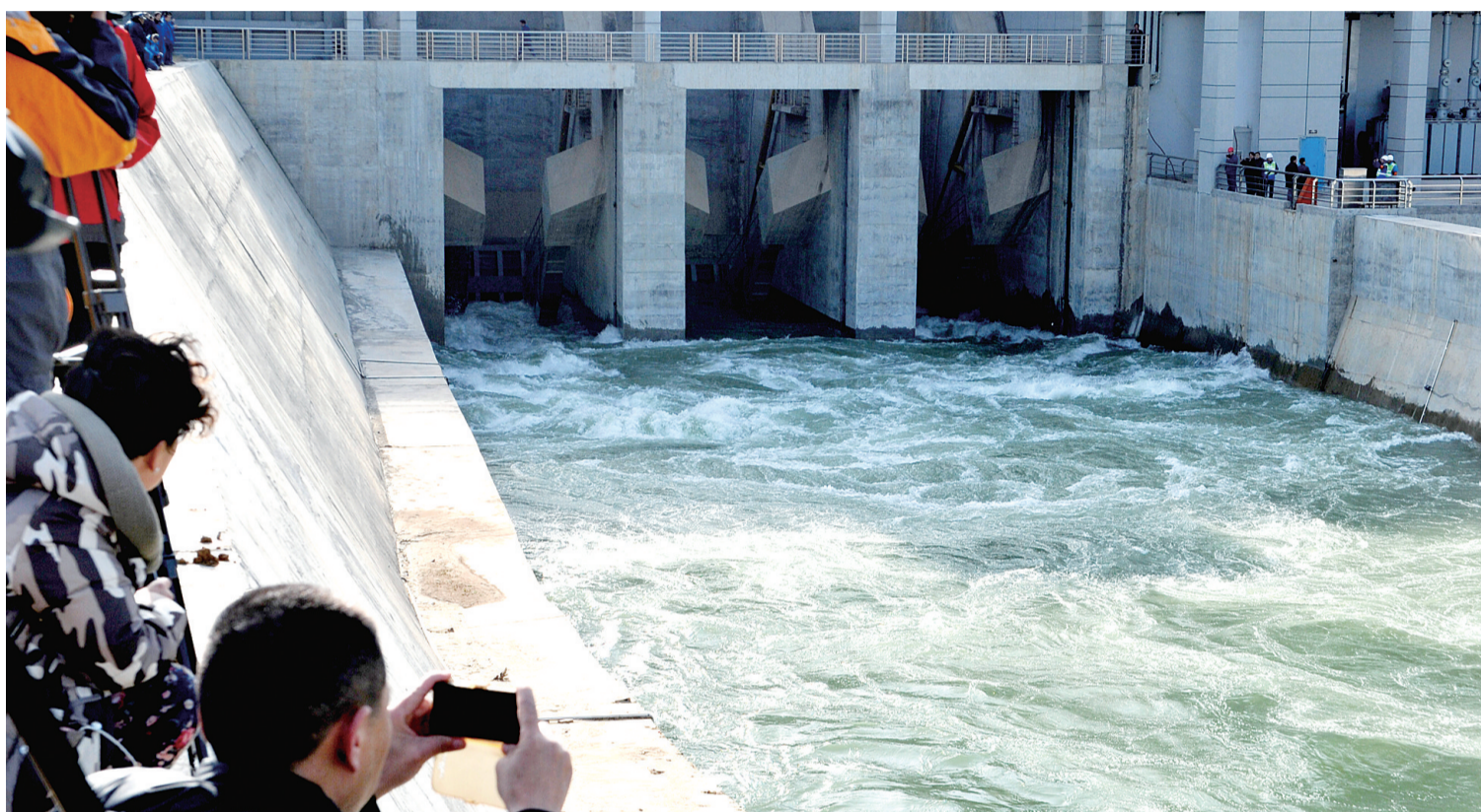
昨日14时32分,渠首闸门正式加大放水。
