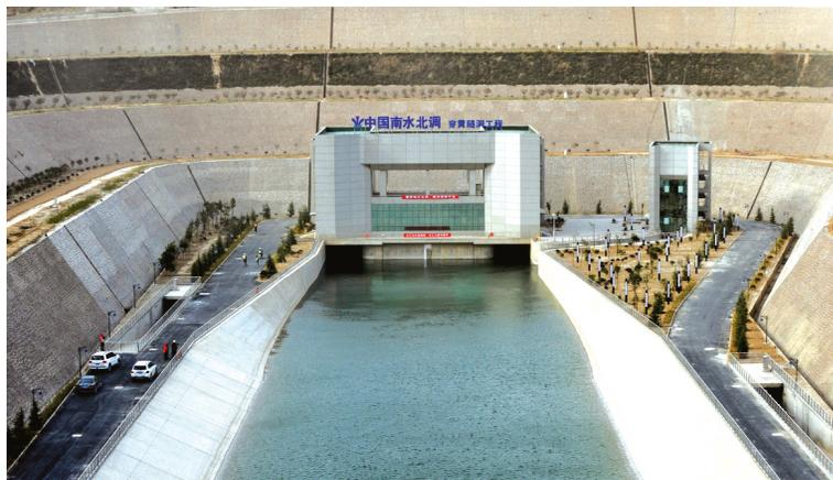
在黄河的下方,建设着两个直径均为7米的隧洞,“南水”通过隧洞继续北上。穿黄隧洞位于黄河河床下深约40多米处,全长4.25公里。昨日,郑州晚报记者到隧洞内进行了体验。郑州晚报记者 王军方/文 周甬/图
