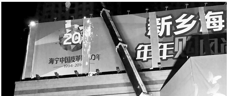
金博大楼顶户外广告牌拆除现场
