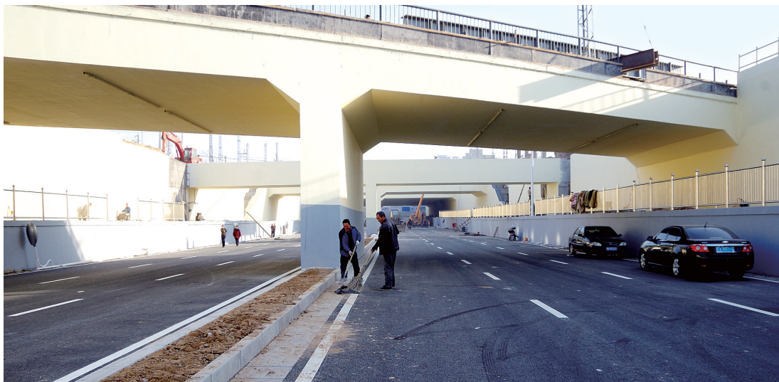
黄河路下穿铁路北编组站隧道收尾
