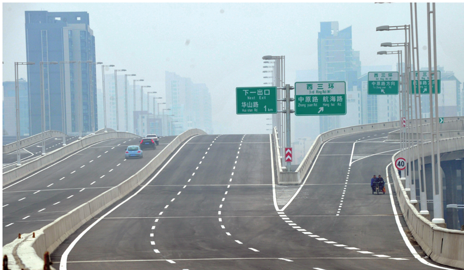
昨日上午,西三环陇海路立交桥上交通标线已划出。
