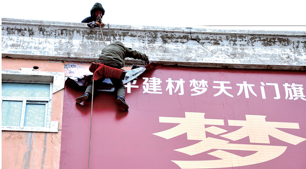
荥阳市城市管理局工作人员正在拆除违法广告
